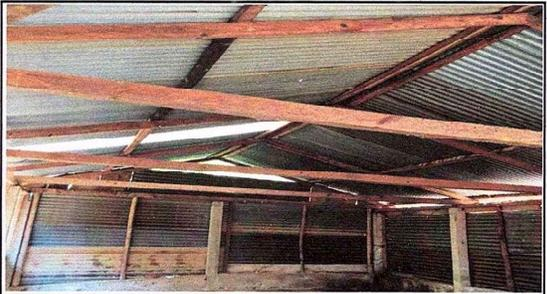
Foto 4: Aula multigrado de Cuarto a Sexto grado y Parvulos. Sustitución de torta de cemento, cubierta de lámina, Costanera y pintura exterior.
