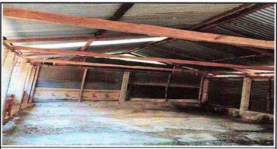
Foto 5: Aula multigrado de Cuarto a Sexto Grado y Parvulos. Sustitución de piso de torta de concreto.
